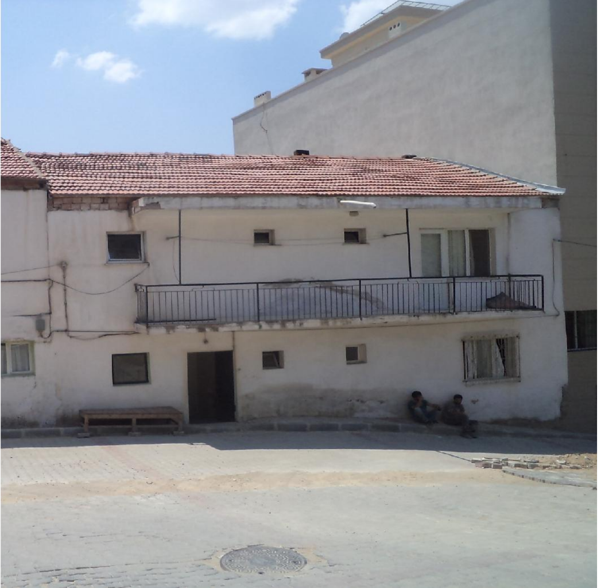
Binanın Ön Cepheden Görünüşü
