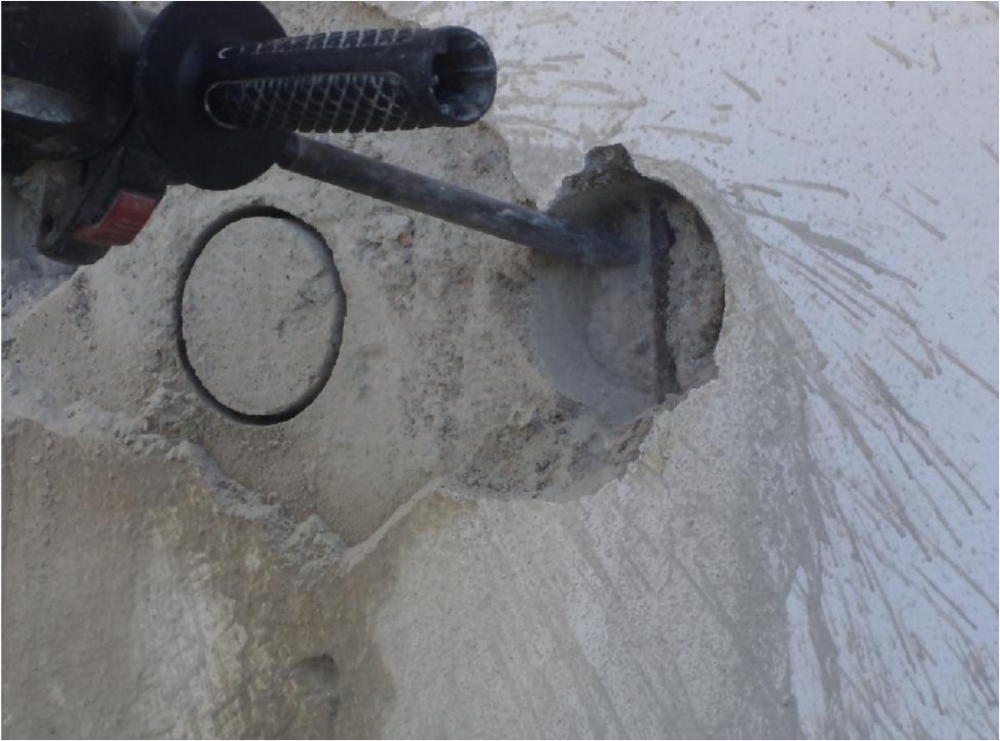
Sıyırma İle Donatı Tespiti
