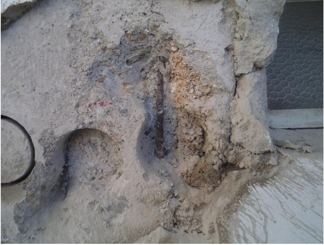
Sıyırma ile Donatı Tespiti
